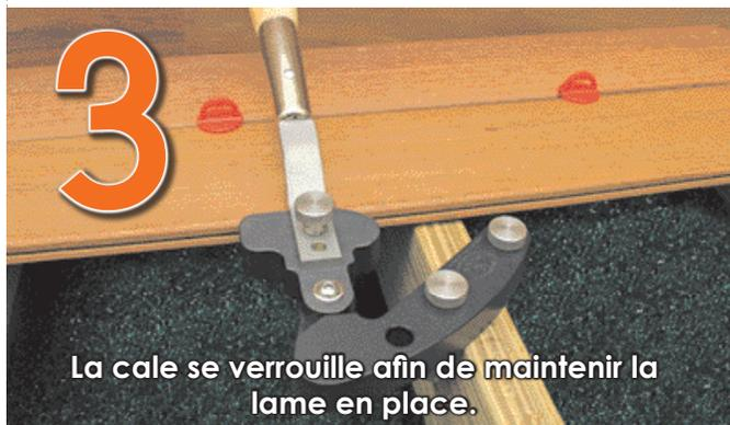
Ajustable pour une utilisation sur des lambourdes jusqu' à 90 mm de largeur
